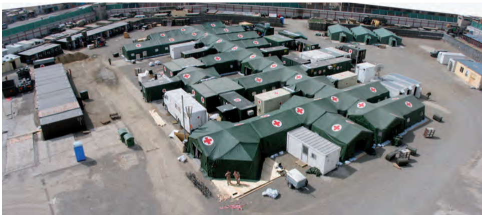
Letecký pohled na polní nemocnici na základně KAIA South (Afgánistán) v roce 2007. Vpředu hlavní vstup do koridoru nemocnice. K hlavnímu koridoru ze zpevněných stanových modulů jsou připojeny kontejnery JIP, operačních sálů, skladů farmacie a CT vyšetřovny. | Foto: archiv autora
