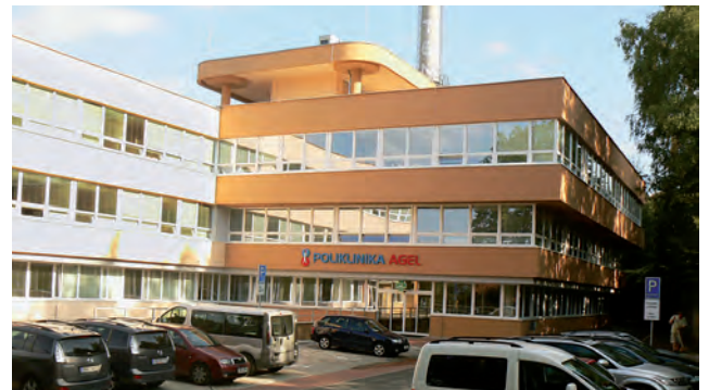
Nová poliklinika v rekonstruovaném areálu Tonaku v Novém Jičíně. | Foto: AGEL
